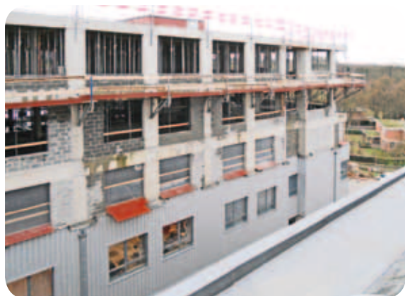
Le nouveau bâtiment fin décembre 2012
