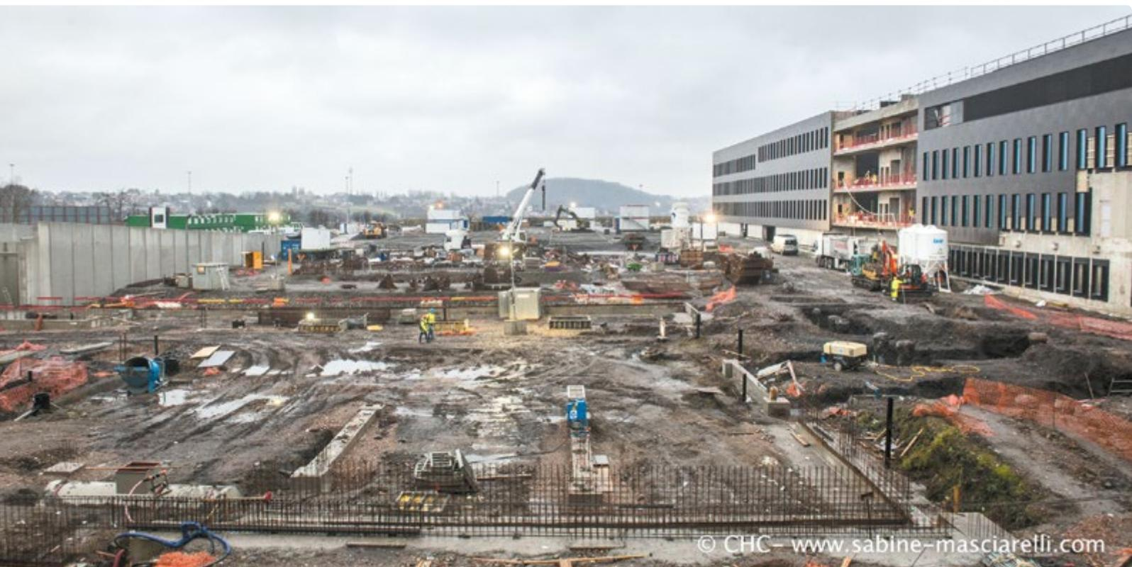
La dalle des urgences constituait la fin du gros œuvre. Commencée début 2017, elle couvre une surface d'environ 3.500 m<sup>2</sup> et se situe un niveau au-dessus du sol. Comme le reste du bâtiment, la dalle a été réalisée à partir d'éléments préfabriqués. Les deux murs imposants qui soutiennent la rampe pour y accéder avaient été mis en place en 2016.
