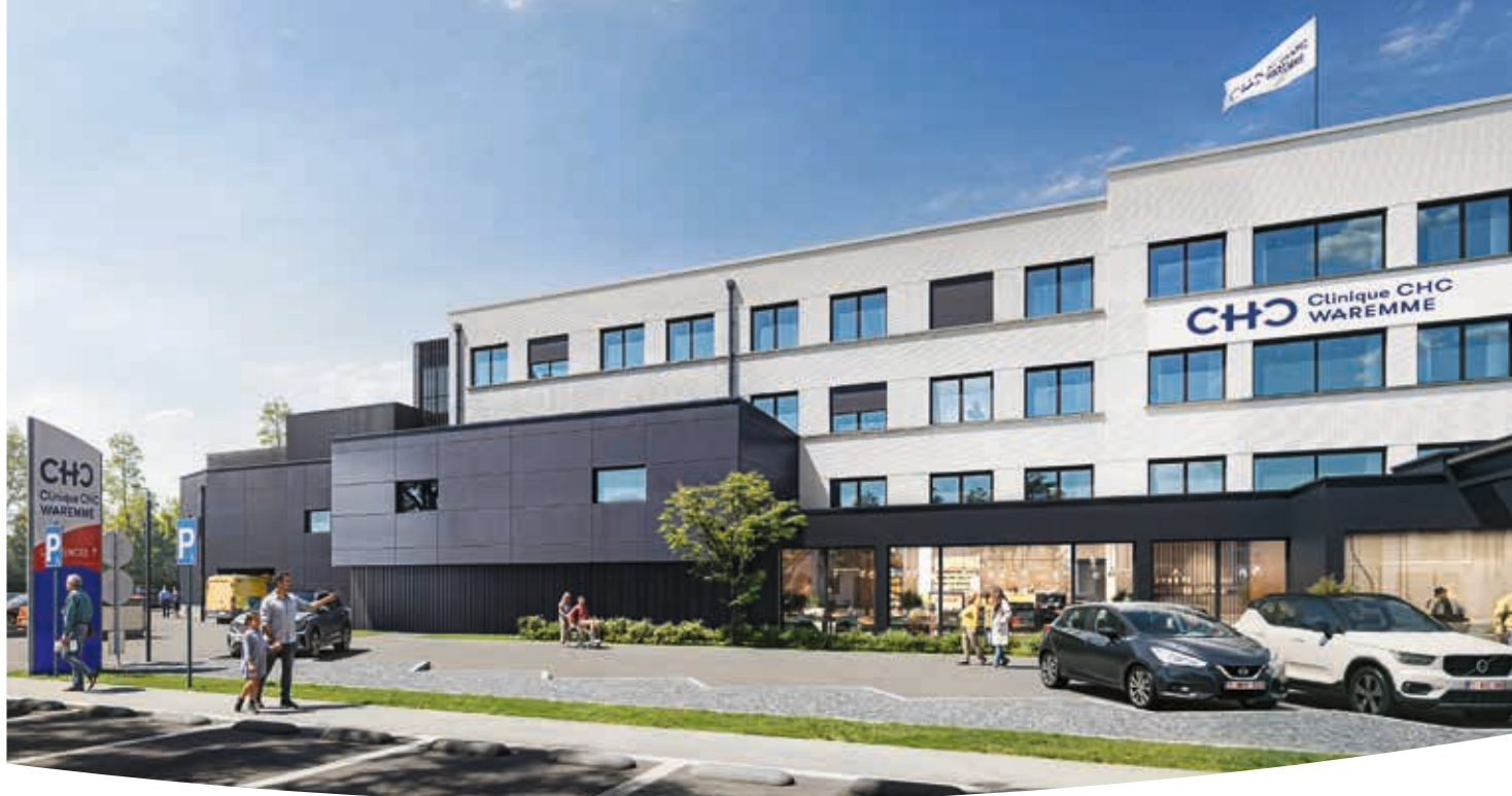
La façade de la clinique après les travaux prévus pour le nouveau bloc opératoire au 1 er étage
